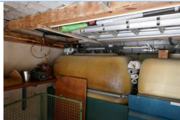
Unterstand mit Öltanks
