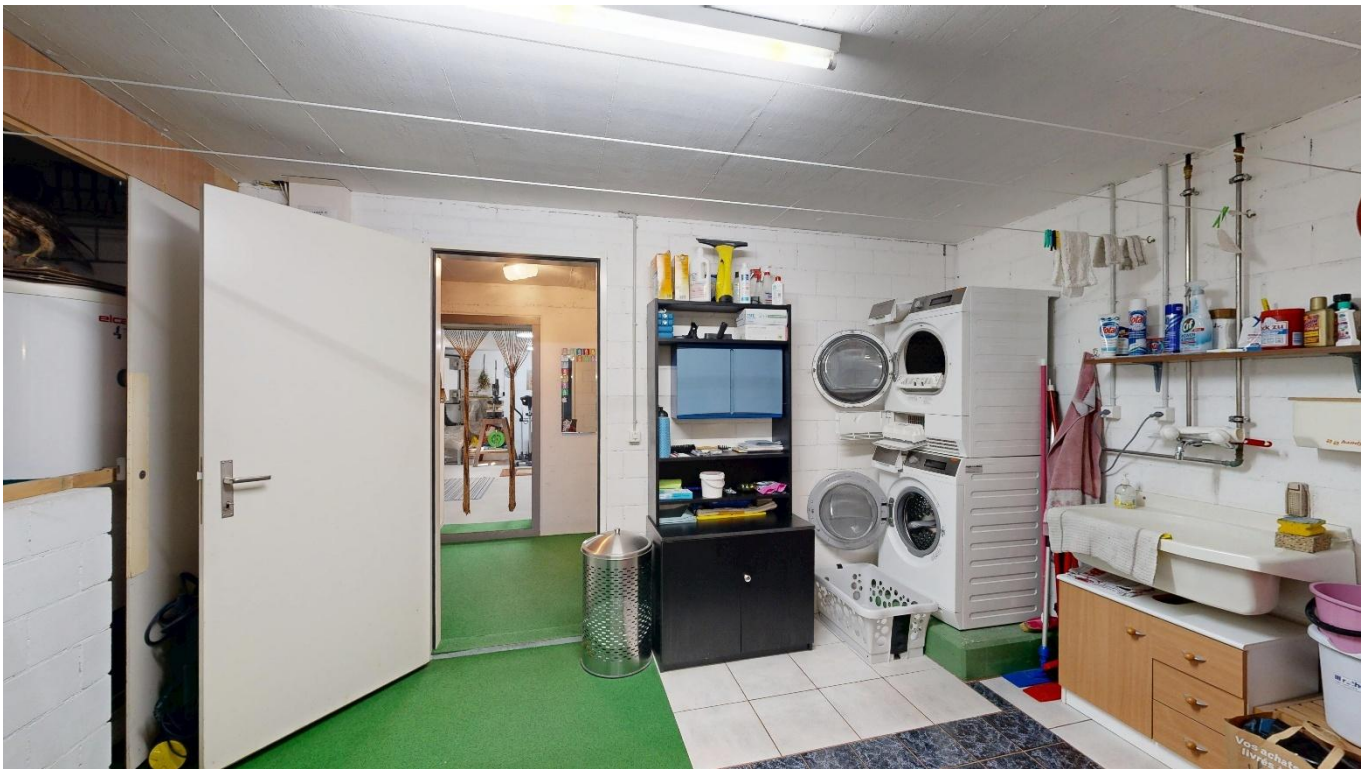
Waschküche/Technik-/Heizungsraum mit Waschmaschine, Tumbler und Lavabo (UG)
