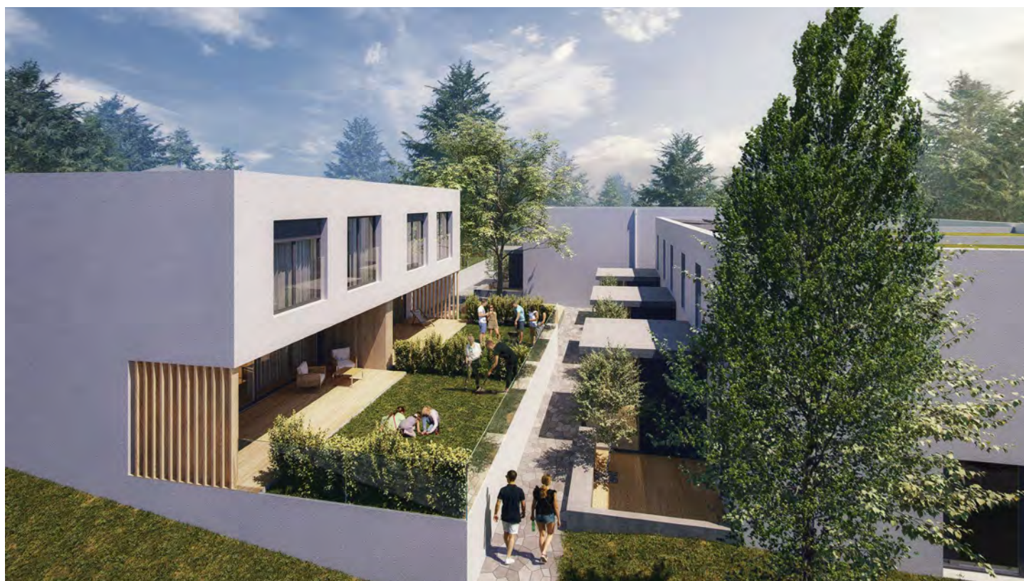
vue du chemin entre les jardins des villas A et les entrées des villas C
